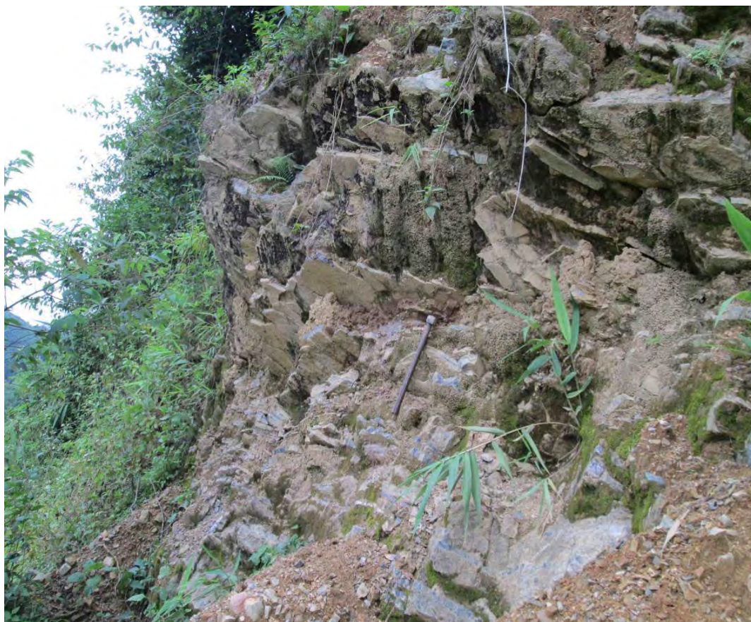
Hình 35: Đá cát kết dạng quartzit bị đập vỡ mạnh gây trượt lở tại điểm BK.060506.DB, xã Quang Phong, huyện Na Rì.
