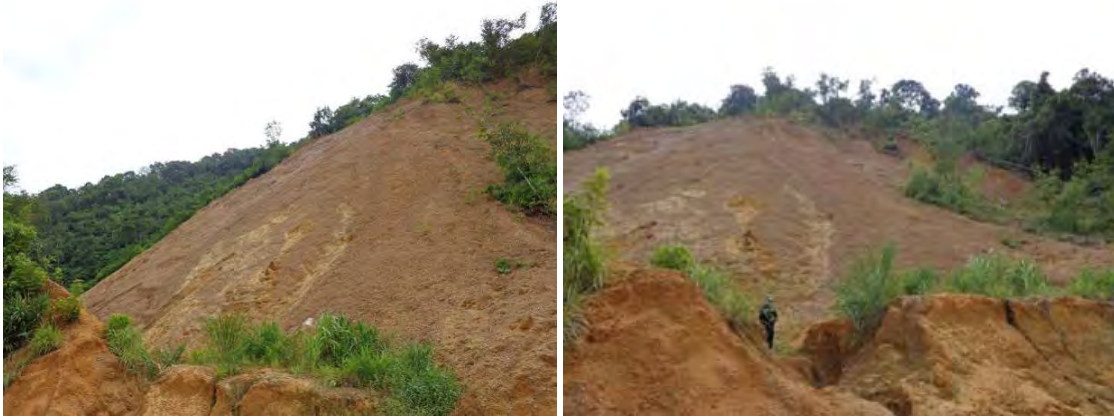
Hình 33: Một số hình ảnh về khối trượt lớn BK.060222.DB xảy ra ở taluy đường thuộc xã Hảo Nghĩa, huyện Na Rì.
