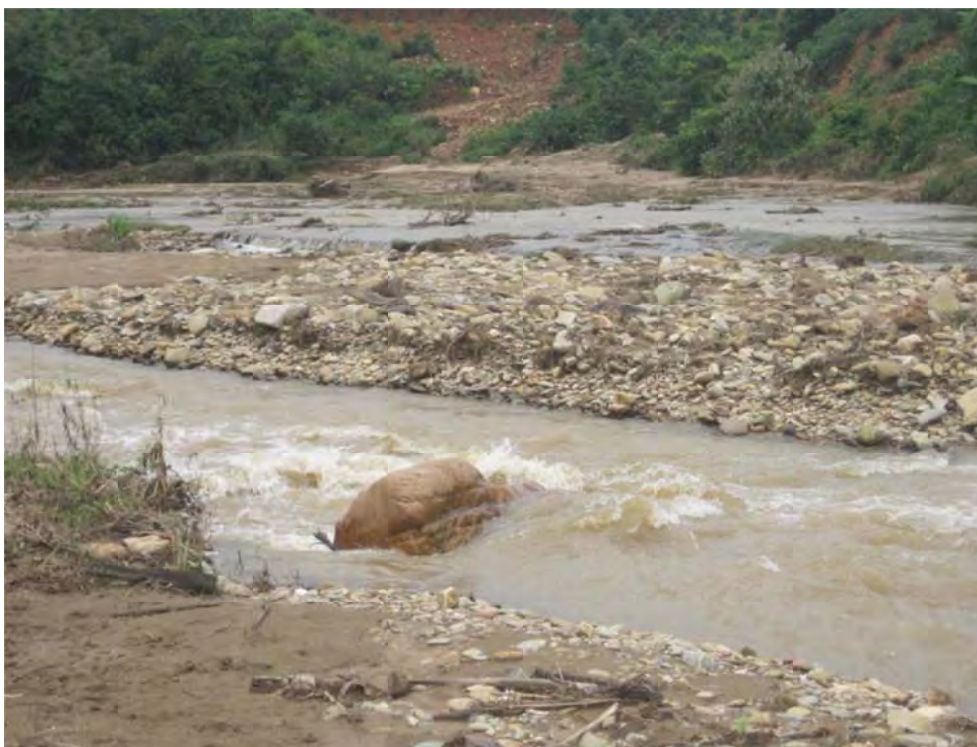
Hình 35: Vị trí xảy ra lũ quét (DB.110309.VL) tại bản Sáng xã Nà Sáy huyện Tuần Giáo tỉnh Điện Biên. Trận lũ quét xảy ra vào đợt mưa ngày 19-20 tháng 07 năm 2013, làm chết 2 mẹ con bà Lò Thị Tun (sinh năm 1972) và cháu Lò Thị Thiêm (sinh năm 1998) trú quán tại bản Nậm Cá (cùng xã Nà Sáy trên đường đi làm về qua).
