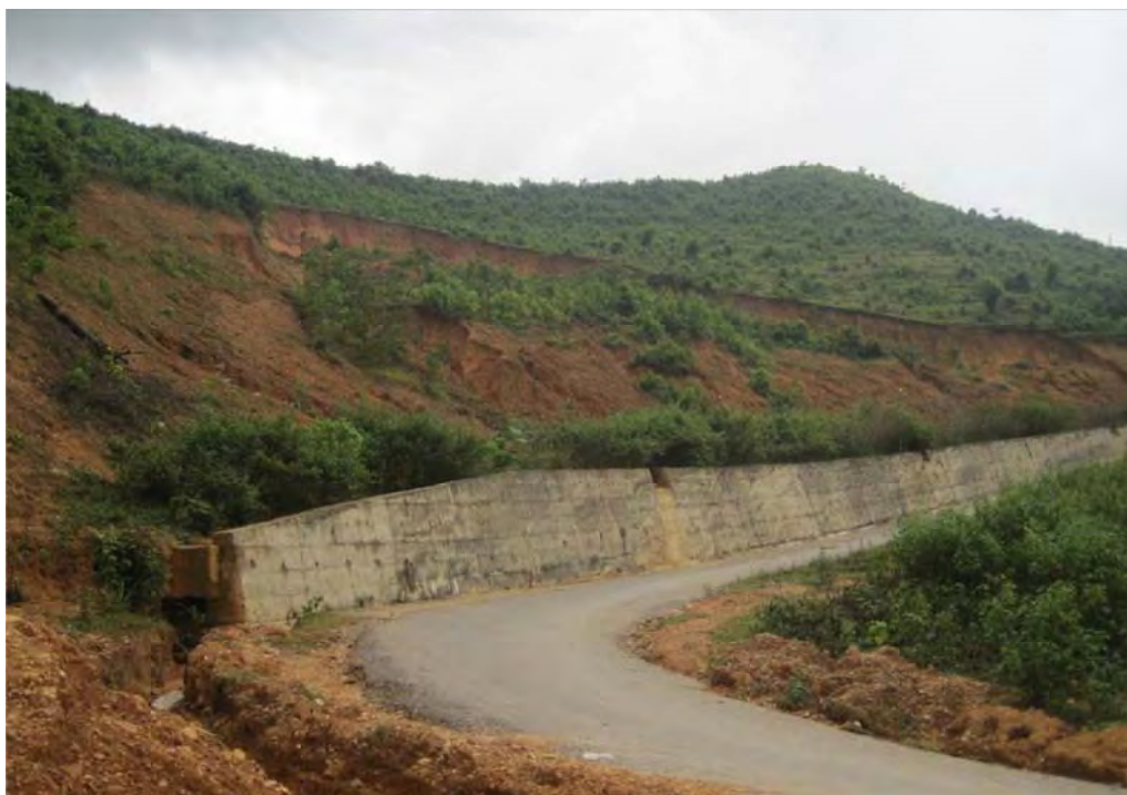
Hình 33: Điểm trượt DB.110329.VL trên vách taluy dương, dọc tuyến đường liên xã, đoạn qua Bản Chấm, xã Mường Thín, huyện Tuần Giáo tỉnh Điện Biên. Trượt lở đất đá xảy ra ngày 06/2011 do hoạt động kiến tạo (sụt lún) làm biến dạng mặt đường. Vỏ phong hóa dày tại đây khoảng 10 m trên nền đá trầm tích thuộc hệ tầng Nậm Pì , thành phần chủ yếu là sét, bột, cát và mảnh vụn đá.
