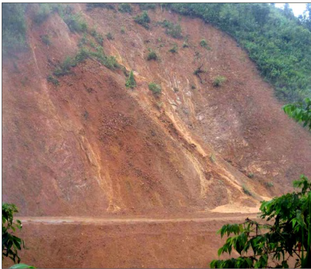
Hình 13: Điểm trượt ĐB.110004/1.VL trên vách taluy dương tại Km58+600 Quốc lộ 279 , đoạn đi qua xã Nà Nhạn, huyện Điện Biên, tỉnh Điện Biên. Trượt lở đất đá xảy ra ngày 26/08/2013 do mưa lớn kéo dài. Lượng đất đá phải giải phóng gần 180.000 m 3 gây ách tắc giao thông trong 5 ngày. Vỏ phong hóa dày gần 30 m trên nền đá xâm nhập Granodiorit , thành phần chủ yếu là sét, bột, cát và mảnh vụn đá.
