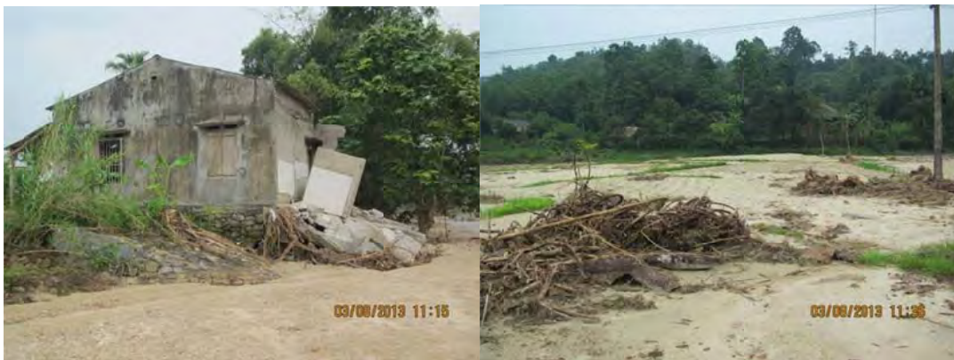
Hình 26: Lũ quét làm sập đổ nhà dân và cầu cống trên địa bàn xã Quảng Ngần, huyện Vị Xuyên
