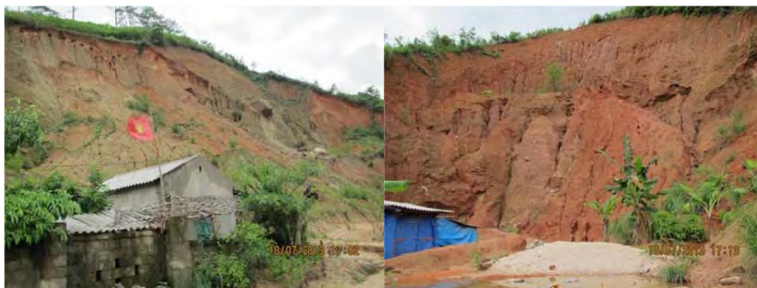
Hình 21: Trượt lở đất đá ảnh hưởng trực tiếp đến nhà dân tại thị trấn Vinh Quang, huyện Hoàng Su Phì
