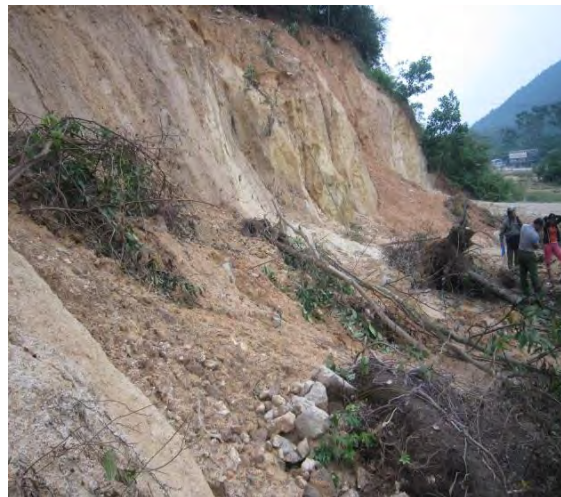
Hình 98 Khối trượt xảy ra trong đá gốc phong hóa mạnh đến hoàn toàn
