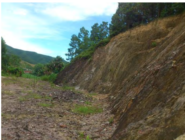
Hình 72: Khối trượt xảy ra theo vách taluy đường Hồ Chí Minh, do cắt xén chân sườn, tạo vách cao, dốc.
