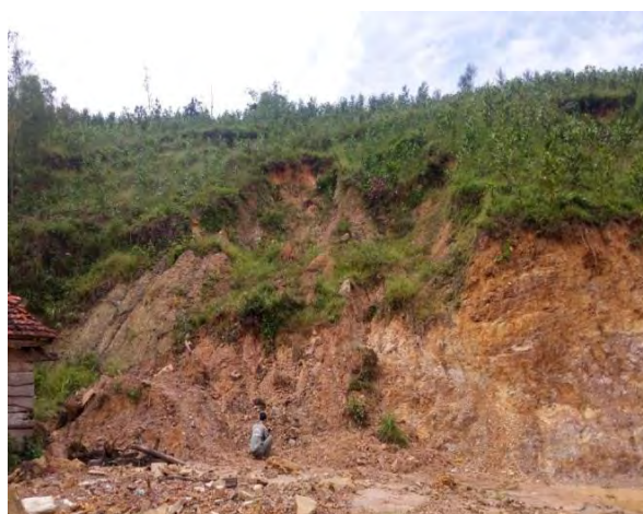
Hình 21: : Khối trượt xảy ra ở sườn nhân tạo tại xóm 5, Hương Lâm
