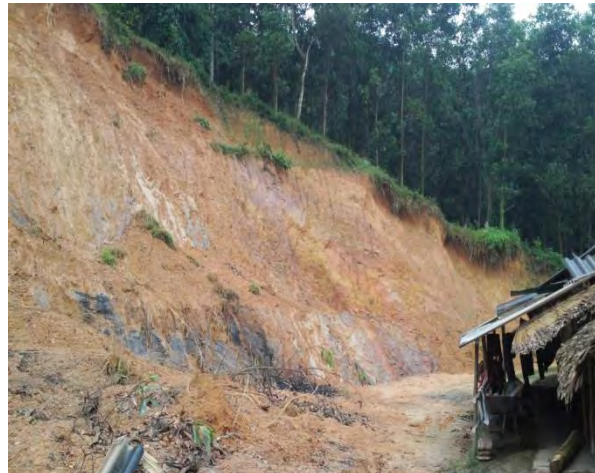
Hình 93: Khối trượt lở xảy ra ở thôn Hạ Vàng, xã Sơn Kim 2 đã gây sập đổ công trình phụ, đất vườn nhà dân
