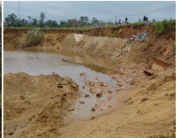
Hình 101: Điểm xói lở bờ sông Bội Nguyên thuộc xóm 2, xã Cẩm Duệ
