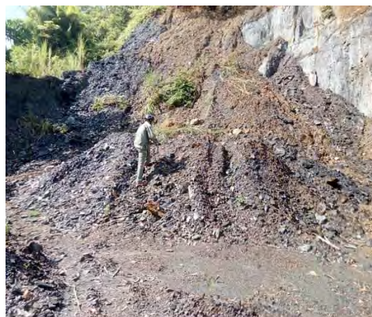
Hình 74: Khối trượt trong đá phiến sét than bị phong hóa dập vỡ mạnh.
