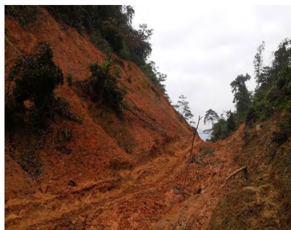
Hình 91: Khối trượt quy mô lớn ở thôn Khe Năm, xã Sơn Kim 1, theo vách taluy đường gây ách tắc giao thông trong nhiều ngày
