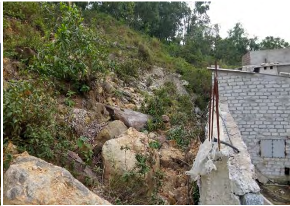
Hình 60: Vật liệu tại chân khối trượt tiến sát chân tường của các hộ dân
