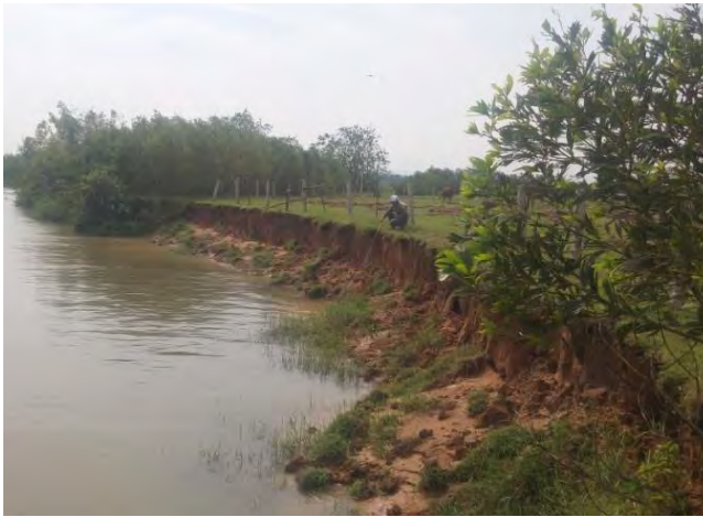
Hình 102: Điểm xói lở bờ sông Rác thuộc xóm 8, xã Cẩm Trung
