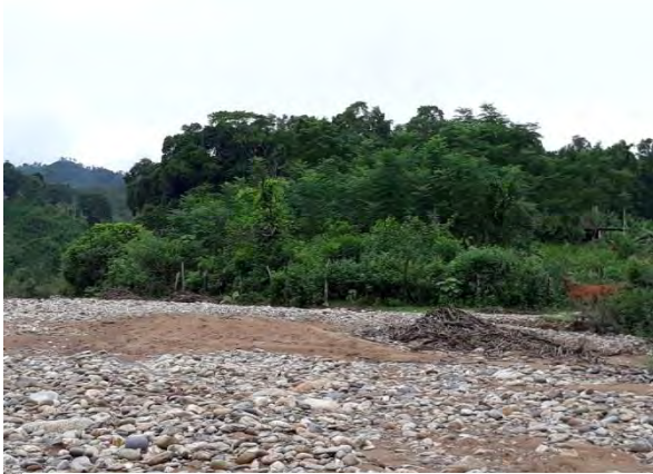
Hình 20: Lũ quét tại xóm Phú Lâm, xã Phú Gia năm 2016 gây hư hỏng nhà ông Hoàng Văn Thái
