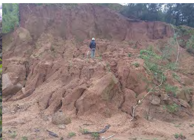
Hình 105: Khối trượt ở sườn nhân tạo thôn 1, xã Cẩm Lĩnh
