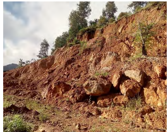
Hình 95 Khối trượt trong đá cát kết, bột kết phong hóa không đều, đá nửa cứng, ngấm nước trở nên bở nhão
