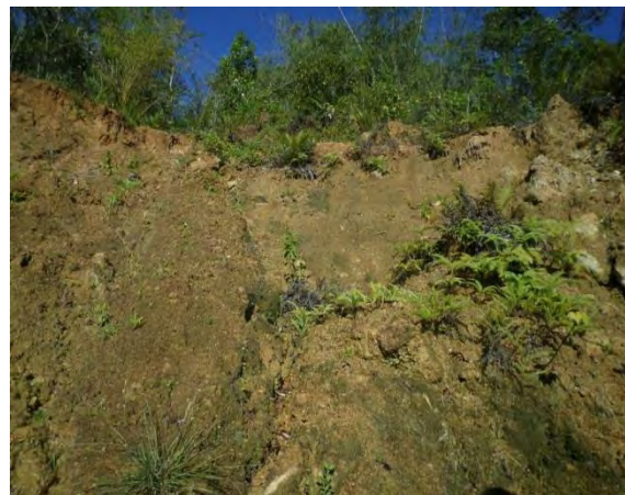
Hình 81: hiện tại thời điểm tháng 9/2017 khối trượt lở vẫn chưa có dấu hiệu hoạt động trở lại
