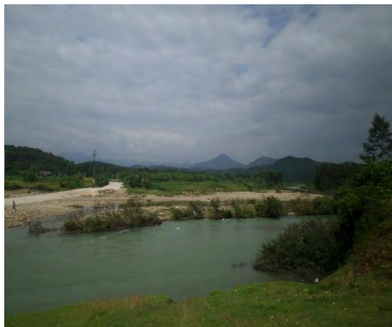
Hình 89: Điểm lũ quét xảy ra vào tháng 10 năm 2013 đã làm cuốn trôi 60m đường giao thông, trôi cầu....
