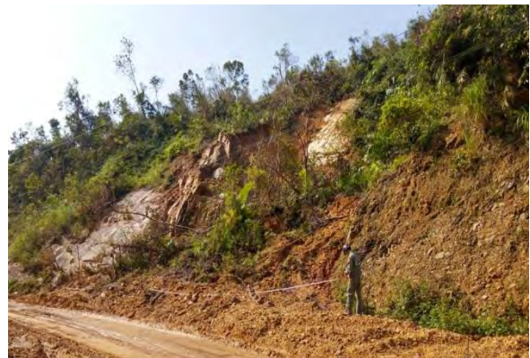
Hình 29: Phần ranh giới khối trượt phía TB đá bị đập vỡ mạnh
