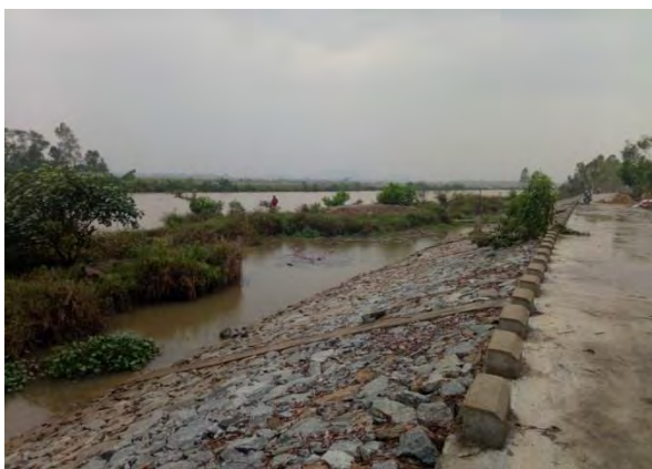
Hình 38: Đê Nghèn (bờ tả sông) khá kiên cố, chưa thấy biểu hiện xói lở
