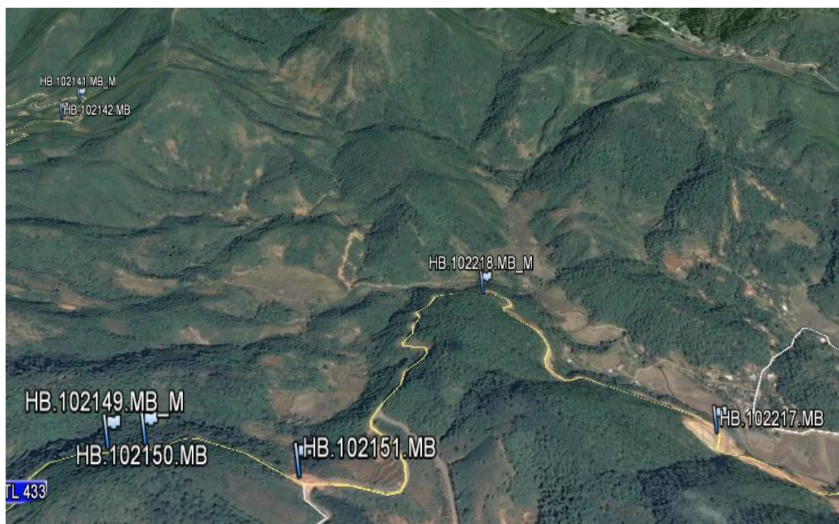
Hình 16. Trượt lở dọc đường tỉnh lộ 433 khu vực huyện Đà Bắc, Hòa Bình: do địa hình dốc cộng với vỏ phong hóa dày nên luôn tiềm ẩn nguy cơ tái trượt, đặc biệt là khi có mưa lớn kéo dài.
