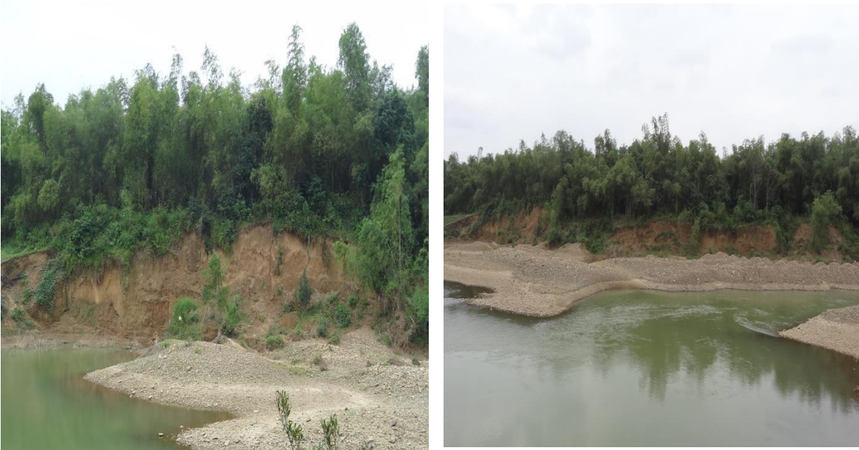
Hình 12. Xói lở bờ sông Bôi khu vực xã Hưng Thi, huyện Kim Bôi.
