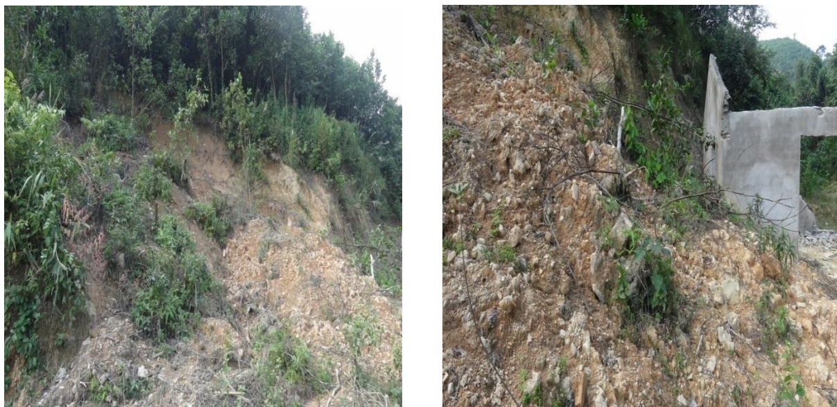
Hình 44. Trượt lở gây sạt sụp đổ nhà dân tại khu vực xóm Hạ 2, xã Lạc Sỹ, huyện Yên Thủy.
