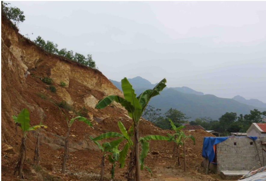
Hình 49. Trượt lở gây nguy hiểm cho nhà dân tại khu vực thôn Mạnh Tiến 2, xã Yên Bồng, huyện Lạc Thủy.
