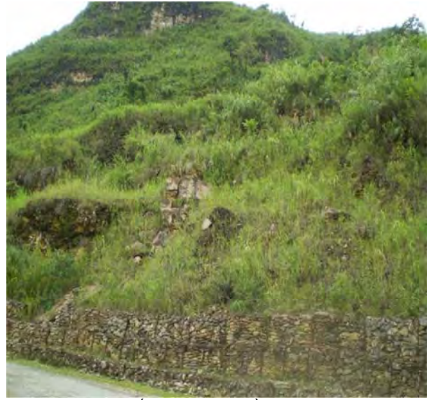
Quang cảnh khối trượt tạo nhiều bậc vách của đá vôi có nguy cơ đá rơi.
