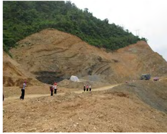
Hình 28. Xảy ra làm hư hỏng nặng đường giao thông.
