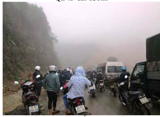
QL4D bị vật liệu tràn xuống đường làm hư hỏng nặng.
