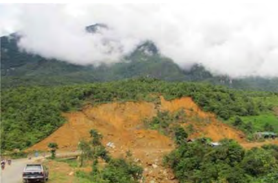
Toàn cảnh khối trượt cầu Nậm Na xảy ra trong đá granit phong hóa mạnh vào ngày 02 tháng 7 năm 2013.
