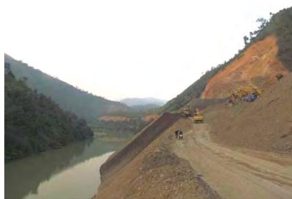
Hình 17: Vách taluy dọc QL12 đoạn qua xã Tả Phìn, Sìn Hồ cao hơn 50m, dốc > 60°.
