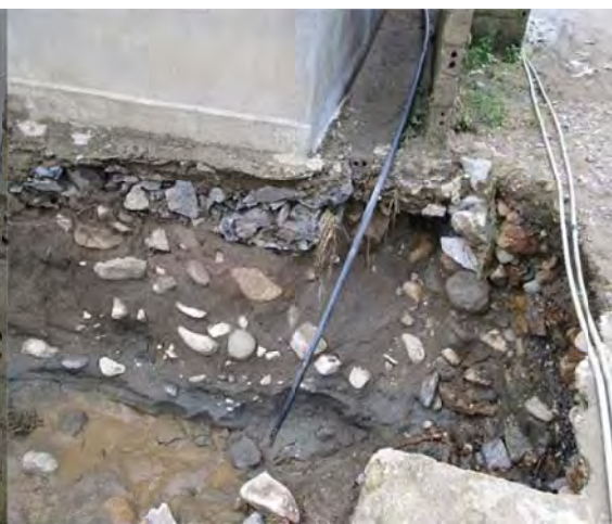
Hình 60. Lũ ống phá hỏng nền móng nhà ở của dân.
