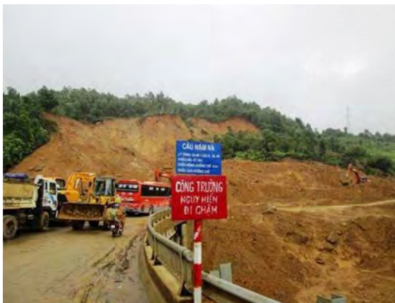
Trượt lở đã làm hư hỏng nặng toàn bộ đoạn đường QL4D dài 150m.
