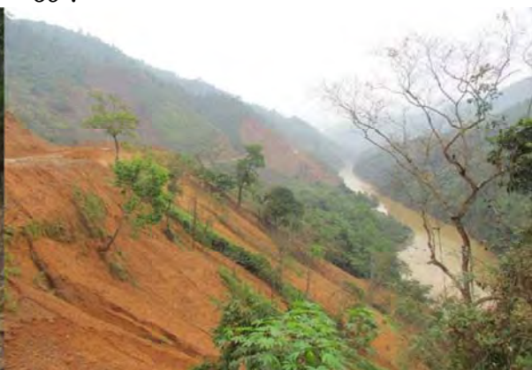
Hình 19: QL12 đang thi công san ủi đất xuống vách taluy âm, đoạn qua xã Hồng Thu, Sìn Hồ
