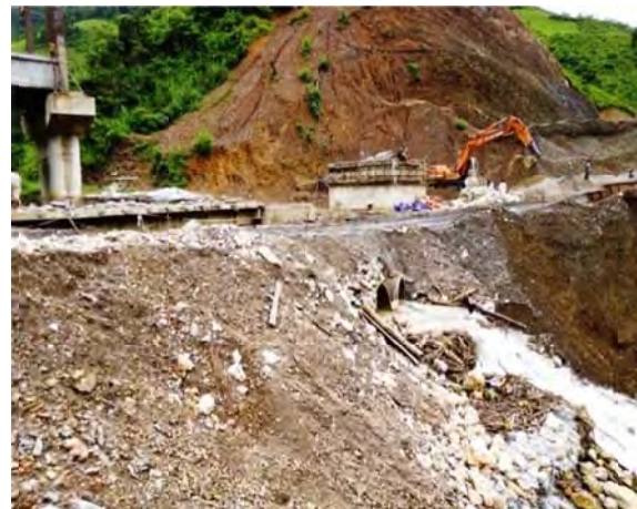
Hình 41. Đơn vị thi công đang làm cầu tạm khắc phục thông xe sau lũ.
