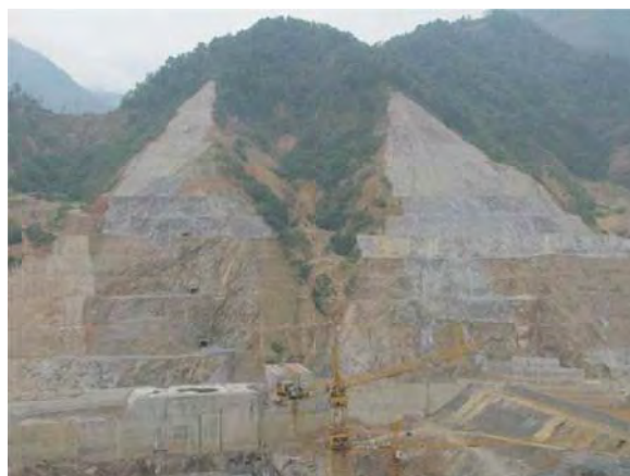
Hình 23: Xây dựng thủy điện Lai Châu san sườn núi cao hàng trăm mét cũng tạo nguy cơ trượt lở.
