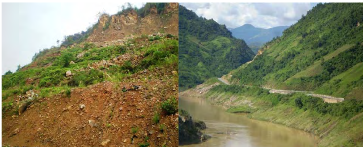
Quang cảnh khối trượt đã được hạ bậc bạt taluy, phần trên đỉnh nhiều tảng đá lớn có nguy cơ rơi. Khối trượt vươn trời ra ngoài sông Nậm Na.
