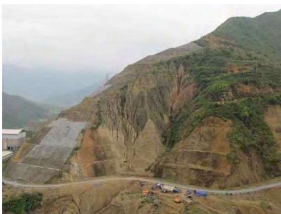
Hình 22: Xây dựng thủy điện Bản Chát san sườn núi cao hàng trăm mét cũng tạo nguy cơ trượt lở.
