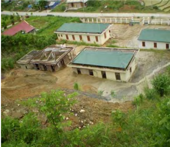
Quang cảnh khối trượt tràn đất đá xuống nhà làm việc của ban quản lý đường bộ 3 Lai Châu.
