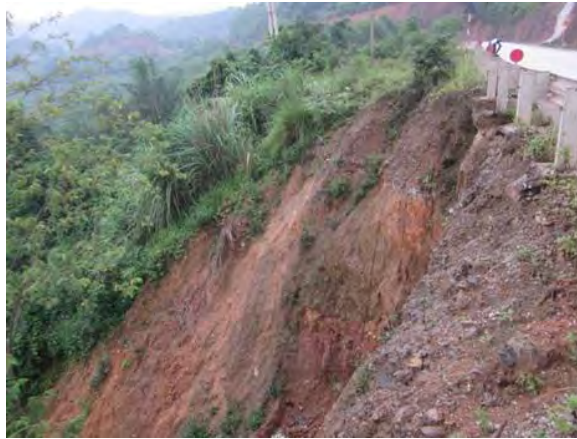
Hình 80. Khối trượt LS.009017.KS tại taluy âm và taluy dương trên QL4A, thôn Bó Mìn, xã Tân Việt, huyện Văn Lãng: đất đá bị phong hóa mạnh, nứt nẻ, dập vỡ, sản phẩm phong hóa bở rời, gồm chủ yếu là cát, sét, bột và mảnh vụn.
