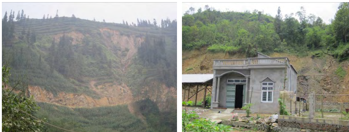
a. Trượt lở đất đá tại Pha Long đe dọa tuyến tỉnh lộ 153 b. Trượt lở đất đá tại thị trấn Mường Khương, đe dọa nhà dân và ách tắc QL4D
