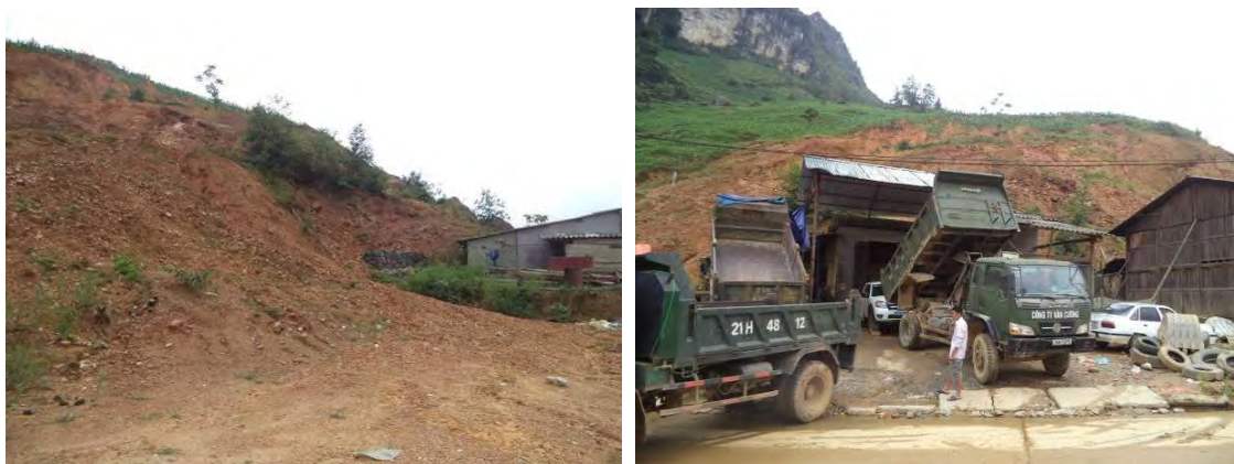
Hình 50. Trượt lở đất đá tại khu Phố Mới, thị trấn Si Ma Cai đe dọa sự an toàn của nhà dân.
