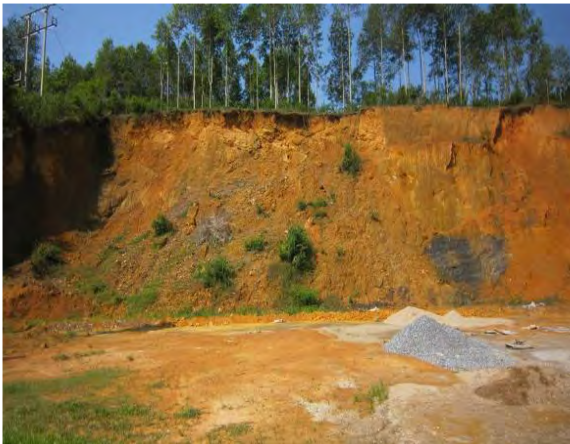
Hình 26: Trượt lở đất đá tại thị trấn Phong Hải, huyện Bảo Thắng đe dọa lưới điện cao thế.
