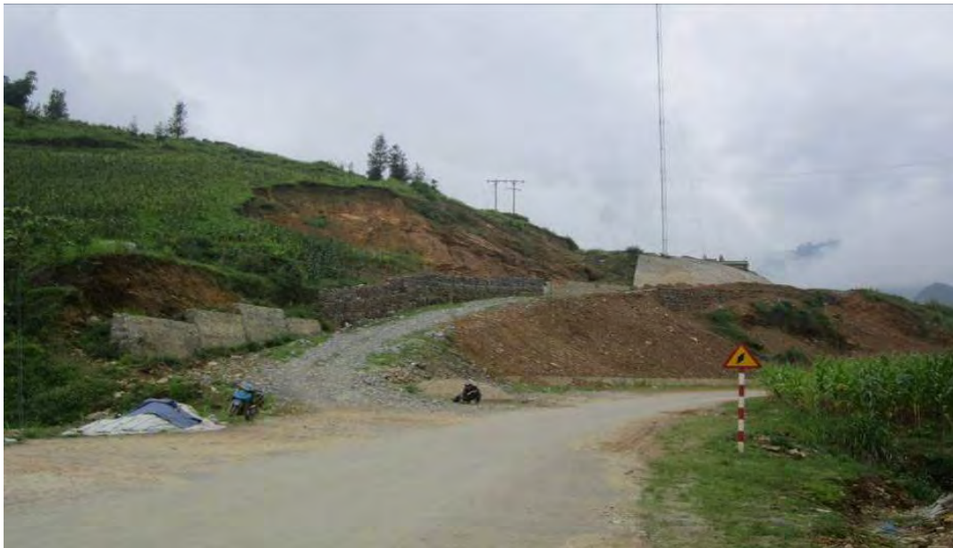
Hình 45. Đường điện cao thế 110KV và cột thu phát viễn thông tại thị trấn Mường Khương, huyện Mường Khương bị đe dọa nếu tiếp tục xảy ra trượt lở đất đá.
