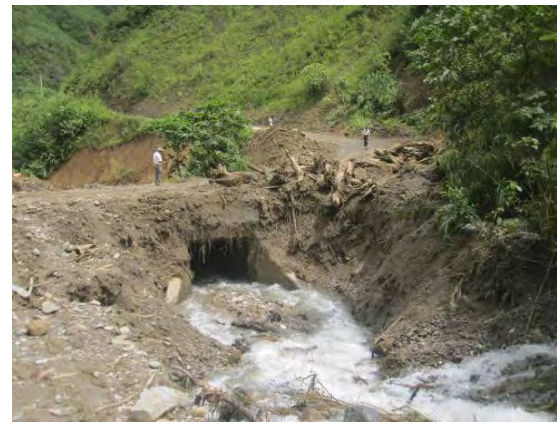
Cống thoát nước nhỏ, ngăn cản vật liệu dòng chảy, gây tắc ứ cục bộ.
