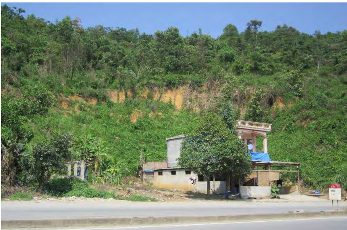
Hình 24: Nguy cơ trượt lở đất đá từ vách taluy dọc Quốc lộ 70 qua xã Bản Cầm, huyện Bảo Thắng, đe dọa tới nhà dân và lưới điện cao thế, cần có biện pháp xử lý.
