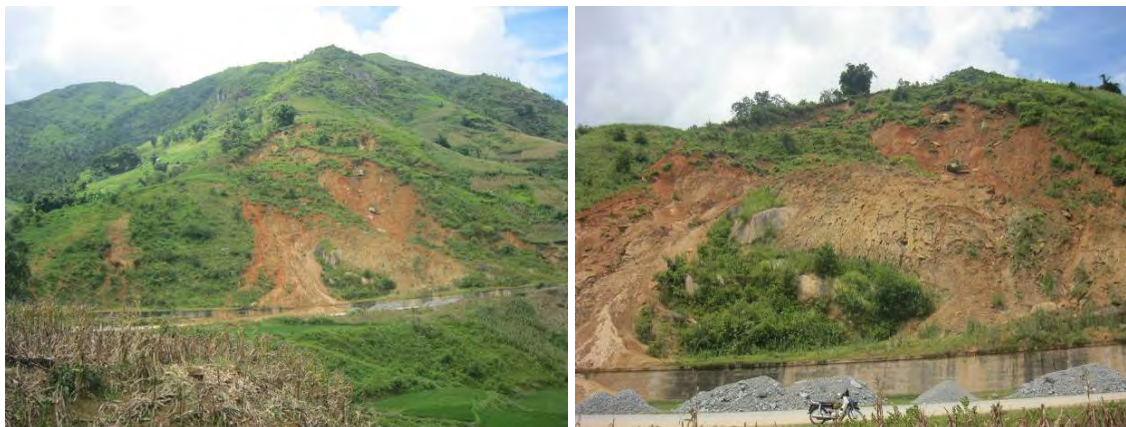
Hình 60. Trượt lở đất đá tại cầu Mống Sến, xã Thanh Kim trên Quốc lộ 4D.
