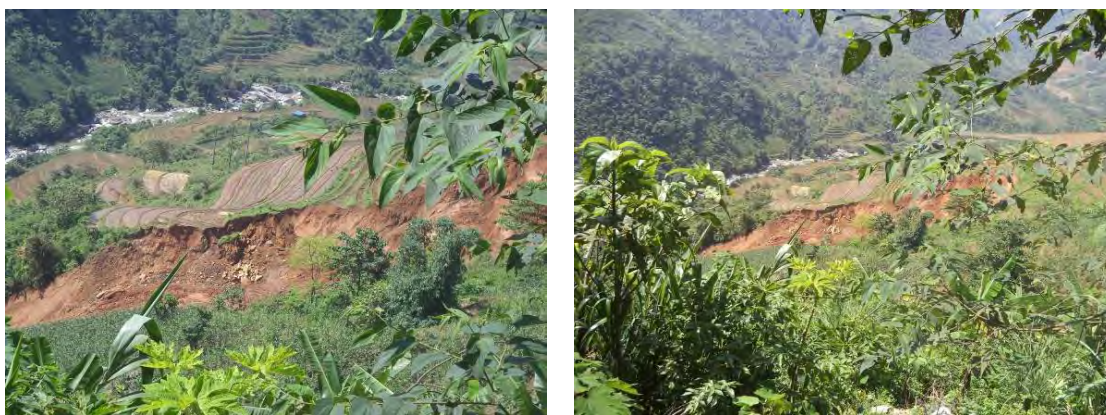
Hình 56. Trượt lở đất đá trên sườn tự nhiên tại thôn Cuồng, xã Tả Phời gây thiệt hại cây cối, hoa màu.
