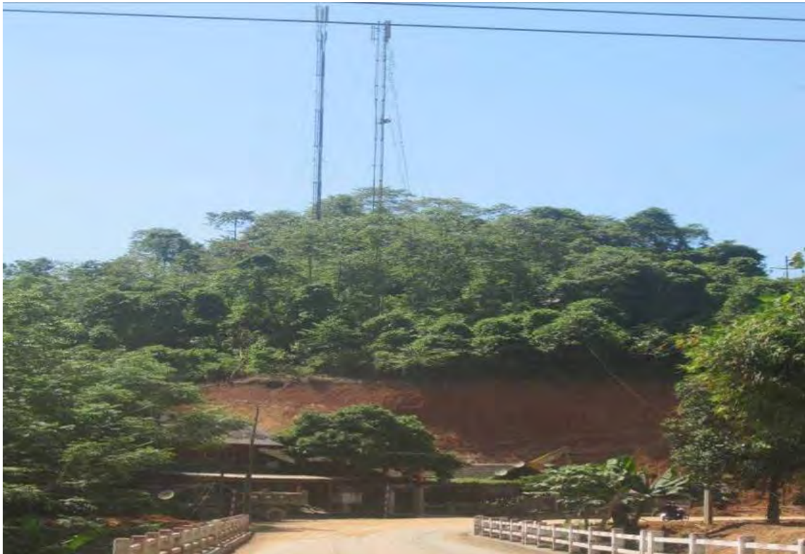
Hình 33. Cột thu phát viễn thông tại xã Lương Sơn, huyện Bảo Yên bị đe dọa nếu tiếp tục xảy ra trượt lở đất đá.
