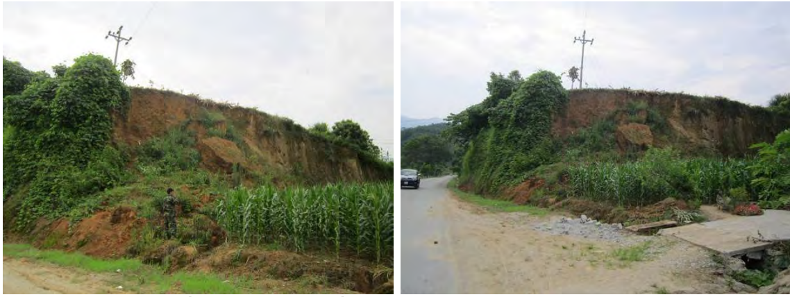
Hình 36. Trượt lở đất đá tại thôn Phố Mới 1, xã Trịnh Tường, huyện Bát Xát đe dọa hệ thống lưới điện cao thế.
