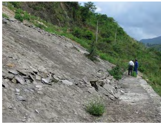
Trên bề mặt thân trượt đã được kè đá nhưng khối trượt dịch chuyển gây trời phá vỡ bề mặt.
