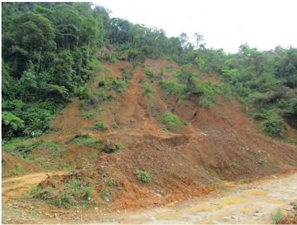
Hình 16: Trượt hỗn hợp (trượt xoay + trượt dòng) trong đá phong hóa của hệ tầng Sông hóa dọc đường đi Huồi Tụ. Hình 17: Trượt xoay trong đá bột kết phong hóa mạnh. Cả ( O_3-S_1sc ) dọc đường Mường Xén - Huồi Tụ; vật liệu trượt là đất đá phiến sét phong hóa mạnh.
