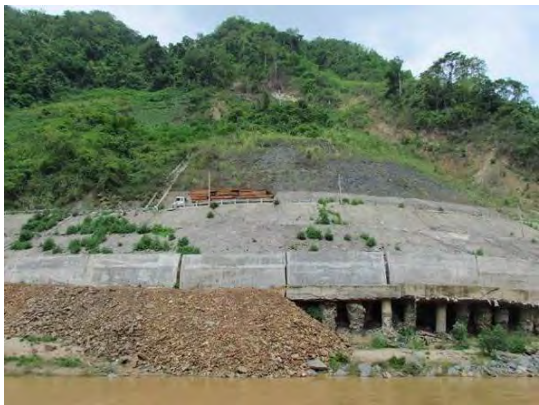
Toàn cảnh khối trượt Sộp Tọc. Ranh giới khối trượt với đá vây quanh khá rõ ràng. Trên bề mặt khối trượt không quan sát thấy trượt
