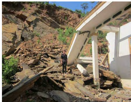
Hình 18: Đất đá phong hóa trượt thành dòng kéo theo nứt, sập Trạm Y tế xã Tà Cạ, khe nứt trong đá hệ tầng Sông Cả gây sập một góc trường Tiểu học Sốp Phe, Mường Típ, nam huyện Kỳ Sơn.
