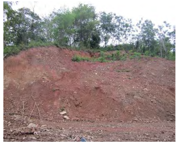
Hình 16: Trượt hỗn hợp (trượt xoay + trượt dòng) trong đá phong hóa của hệ tầng Sông hóa dọc đường đi Huồi Tụ. Hình 17: Trượt xoay trong đá bột kết phong hóa mạnh. Cả ( O_3-S_1sc ) dọc đường Mường Xén - Huồi Tụ; vật liệu trượt là đất đá phiến sét phong hóa mạnh.
