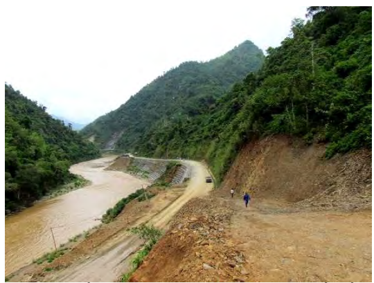
Trượt lở kết hợp xói lở bờ sông đe dọa mất nền đường Quốc lộ 7
