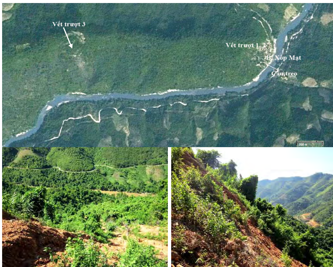
Hình 32. Hình ảnh vết trượt tại Sốp Mạt nhìn từ ảnh vệ tinh. Vết trượt 3 hướng thẳng xuống sông Nậm Nơn với góc dốc mặt trượt 40-45°.
