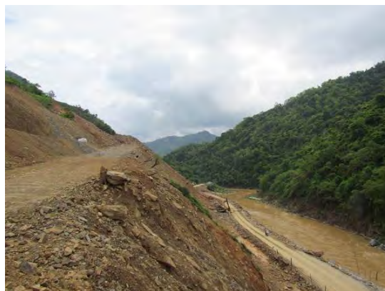
Hạ bậc trên thân khối trượt để tạo nền đường mới
