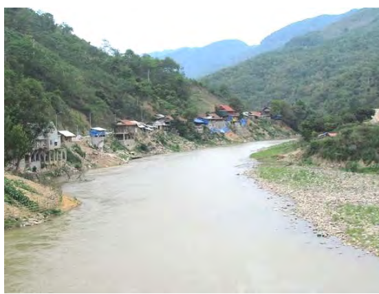
Hình 10: Xói lở bờ sông khu vực thị trấn Mường Xén, huyện Kỳ Sơn, khiến nhiều nhà dân có nguy cơ sạt lở xuống sông.
