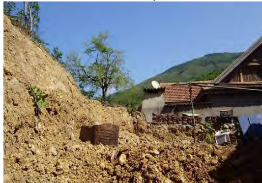
Đất đá trượt từ vách taluy dương xuống gây sập nhà dân.
