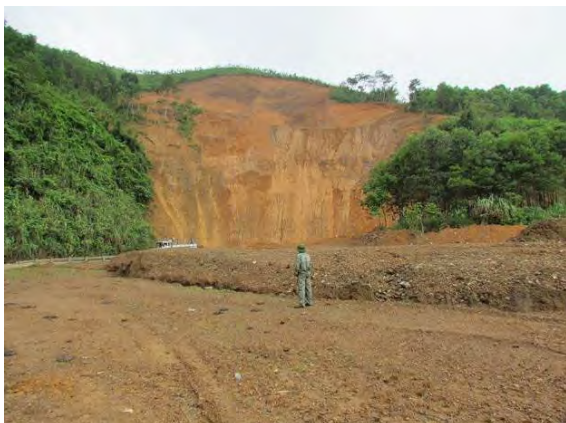
Hình 28: Trượt xoay trong đá phong hóa dọc vách taluy đường vào thủy điện Bản Vẽ. Thực vật trên đỉnh khối trượt kém phát triển hơn so với xung quanh.
