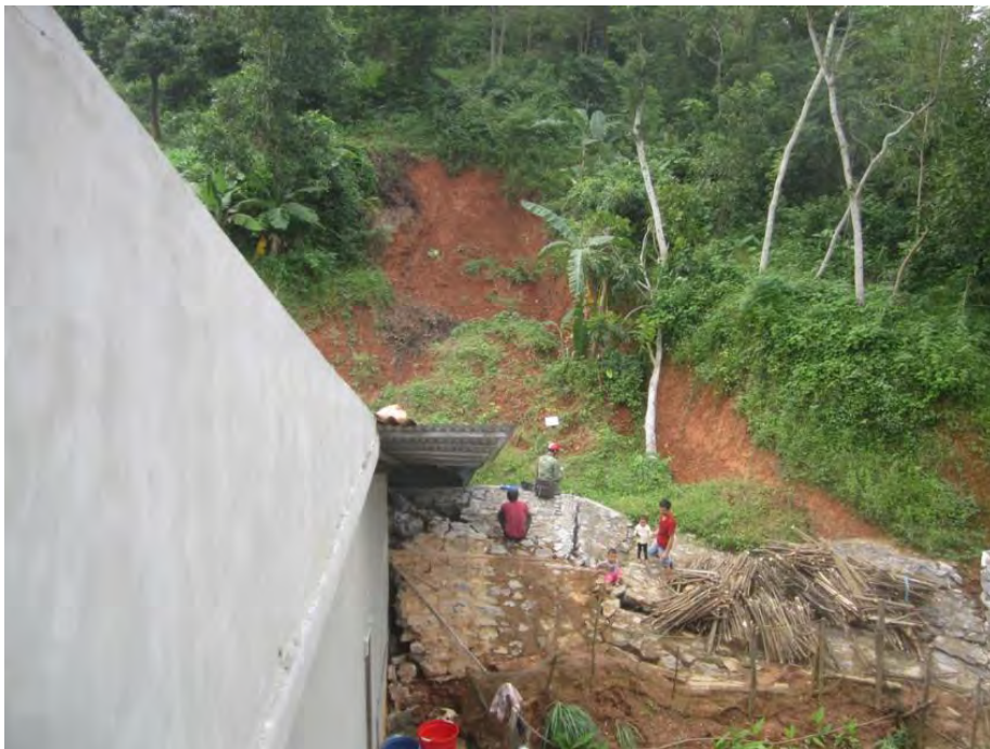
Hình 61. Nhà dân xây dựng trong khu vực ảnh hưởng của khối trượt đã bị hư hại tại thôn Xuân Sơn - xã Sơn Trạch - huyện Bố Trạch.
