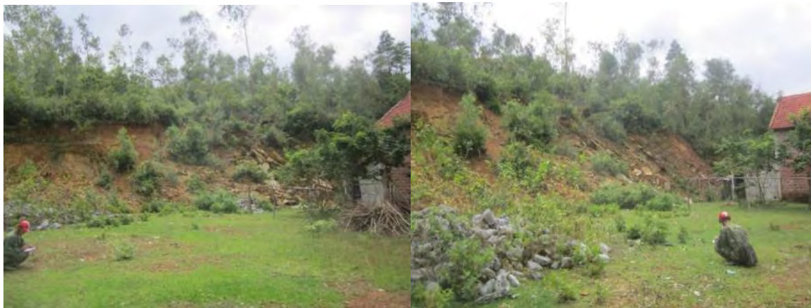
Hình 29. Hình ảnh khối trượt QB.031005.TB thuộc xã Hưng Trạch, huyện Bố Trạch: trên khối trượt có thảm thực vật che phủ trung bình,, vật liệu chủ yếu là sét, mảnh hòn đá phiến sét sericit màu xám nâu, nâu đỏ.
