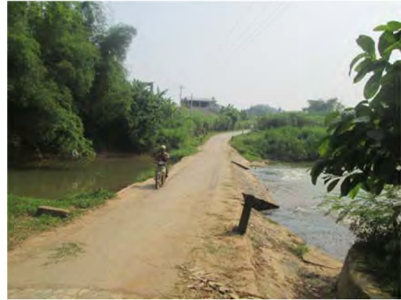
Điểm xảy ra lũ quét tại xã Thái Hòa, Hàm Yên; do xây ngầm chắn ngang
