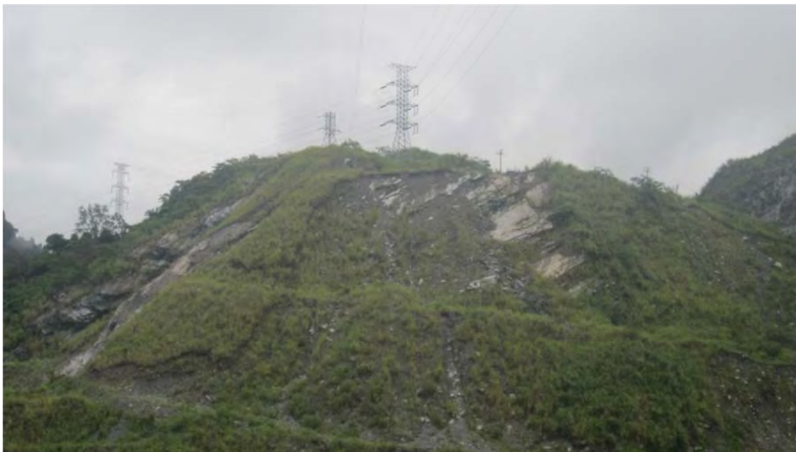
Hình 46. Nguy cơ trượt lở đất đá có thể xảy ra đe dọa hệ thống đường dây điện cao thế tại xã Sơn Phú, huyện Na Hang
