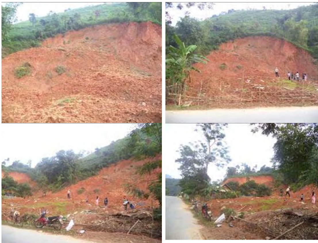
Hình 29. Một số hình ảnh về điểm trượt lở YB.110365.L2 tại thôn 2, xã Tân Lĩnh
