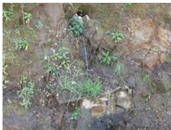
Điểm xuất lộ nước ngầm tại vách taluy đường - bản Cù Gì Seng, xã Lao Chải.
