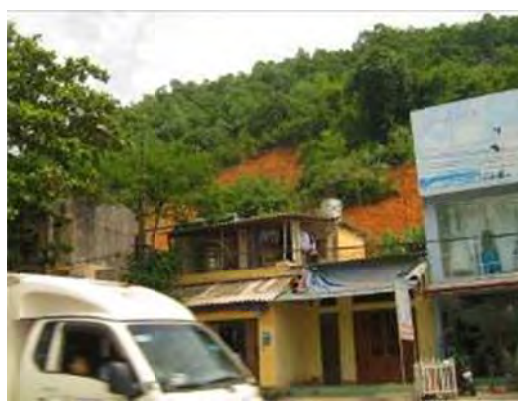
Trượt lở taluy ảnh hưởng tới nhà dân tại tổ 7, TT.Yên Bình. Số hiệu YB.110016.L2
