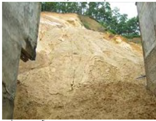
Kiểu trượt hỗn hợp, quy mô lớn gây hư hỏng nhà dân tổ 11, phường Yên Ninh
