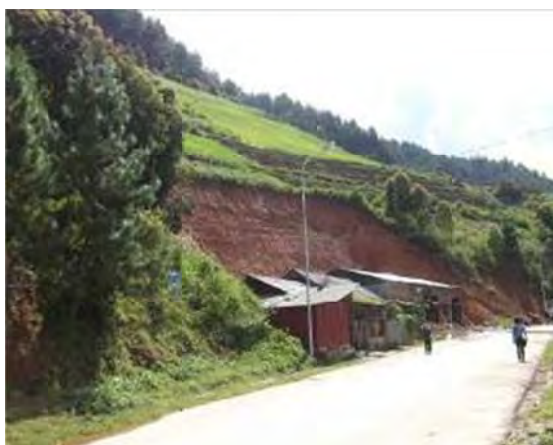
Điểm xẻ taluy làm nhà cửa cạnh đường Quốc lộ 32 - tại tổ dân phố số 9, thị trấn Mù Cang Chải.
