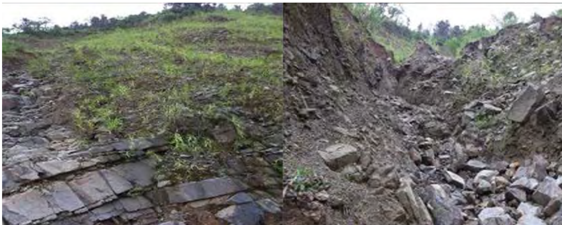
Hình 38. Dập vỡ kiến tạo tại vách taluy đang liên quan tới đứt gãy tại Quốc lộ 32, tại bản Trống Là, xã Hồ Bố. Số hiệu ảnh YB.230044.L2
