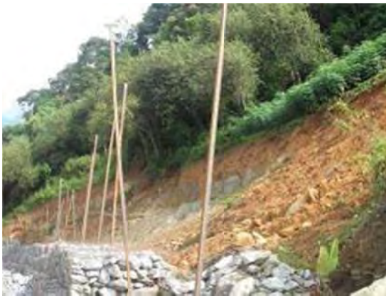
Điểm trượt lở tại sườn núi, ảnh hưởng nhà dân tại bản Khẩu Ly, xã Bản Mù Số hiệu YB.260031.L2
