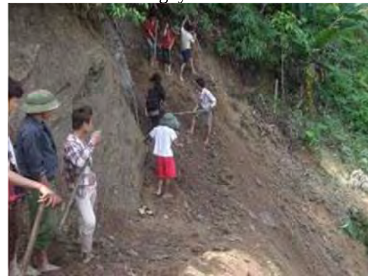
Trượt taluy đường làm lấp cả đường giao thông vào tháng 7/2013 tại thôn Vàng Ngân, xã Suối Quyền. Số hiệu YB.210102.L2 Ảnh: Thái Minh Hải
