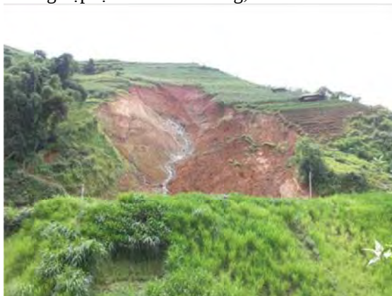
Điểm trượt lở tại vách taluy dương Quốc lộ 32, tại bản Pú Nhu, xã Púng Luông.
