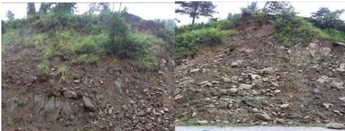
Hình 39. Dập vỡ kiến tạo tại vách taluy đường Quốc lộ 32 - bản Khao Mang , xã Khao Mang (Số hiệu ảnh YB.230036.L2)
