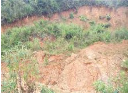
Trượt lở sườn núi, thuộc khu vực dân cư tại tổ dân phố 3, TT.Trạm Tàu
