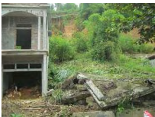
Trượt lở làm sập và hư hỏng nhà dân tại thôn Đồng Tha, xã Phúc An. Số hiệu YB.120778.L2.
