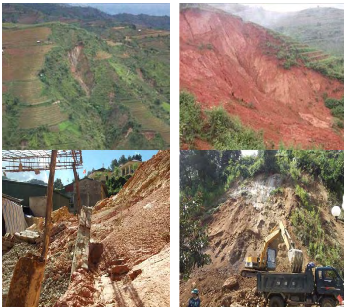
Hình 43. Một số hình ảnh các kiểu trượt trên các sườn đặc trưng, ở các khu vực sử dụng đất tiêu biểu trong địa bàn huyện Mù Cang Chải
