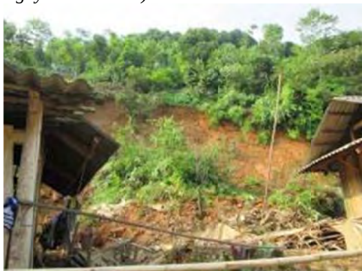
Trượt lở sườn núi gây hư hỏng nhà dân tại thôn 1, xã Phúc Lợi.
