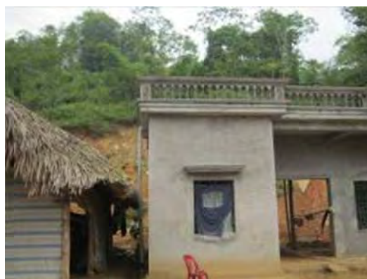
Trượt lở taluy làm hư hỏng nhà bà Ánh Thị Kỳ tại thôn Yên Mỹ, xã Xuân Lai. Số hiệu YB.120707.L2.
