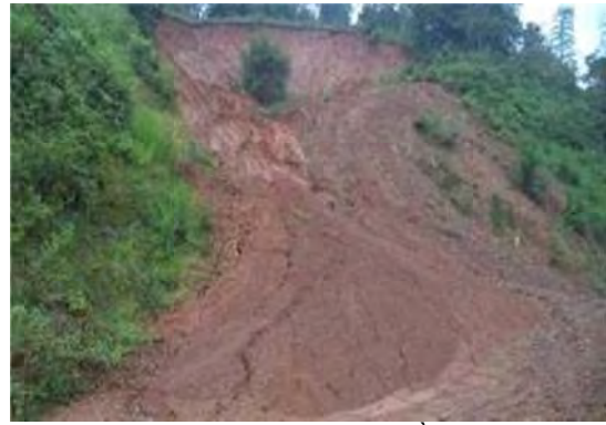
Trượt lở sườn núi, thuộc khu trồng cây nông nghiệp tại thôn Tầu Dưới, xã Trạm Tàu
